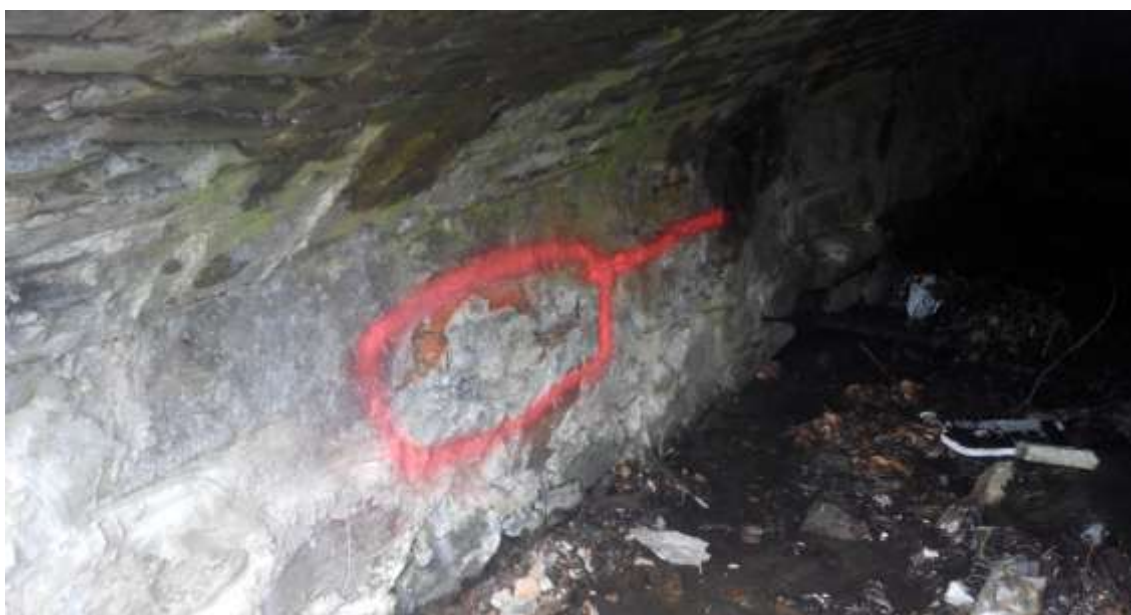
Obr. 3 – Poškozené zdivo v úrovni kolísání hladiny potoka
